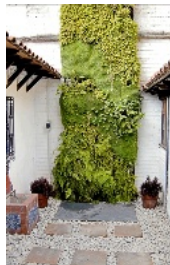
► Las plantas se aferran al muro sobre una tela que se riega con aspersores automatizados.
